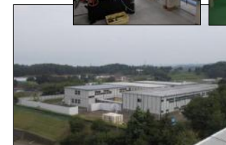
仮設校舎と仮設実習棟機械工作室・農産加工室 (宮城県農業高等学校)
