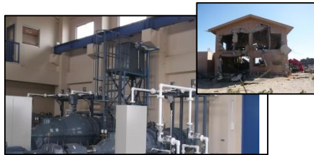
復旧した花笠第2排水機場 (山元町)
