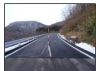
復旧した林道 高倉線(大和町)
