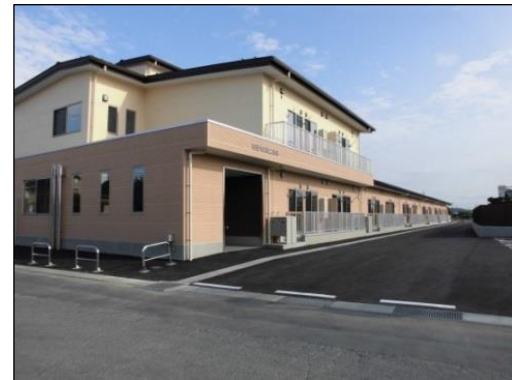
災害公営住宅整備状況(登米市迫西大網第二地区)
