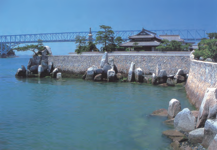
下蒲刈、蒲刈大橋の防潮堤修景デザイン（伊藤邦衛設計部分）
